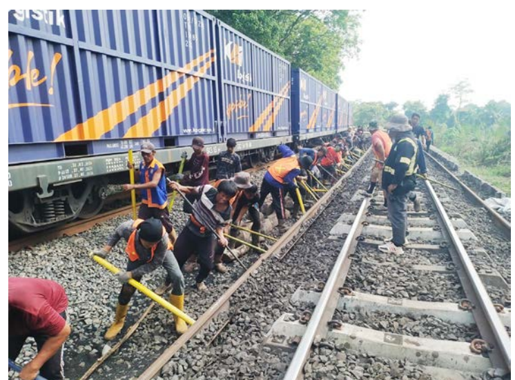
BERJIBAKU: Sejumlah pekerja PT KAI Divre III Palembang berjibaku melakukan pekerjaan penggantian rel KA di jalur KA Stasiun Ujan Mas hingga Stasiun Penanggriran di wilayah Muara Enim sejauh lima kilometer, beberapa waktu lalu. FOTO : ISTISUMEXS
