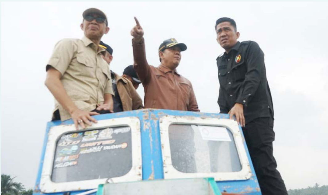
Pimpinan dan anggota DPRD Kabupaten Muba monitoring langsung ke lokasi pembangunan jembatan P6 Lalan, Kecamatan Lalan, yang sebelumnya ambruk akibat ditabrak kapal tongkang.
