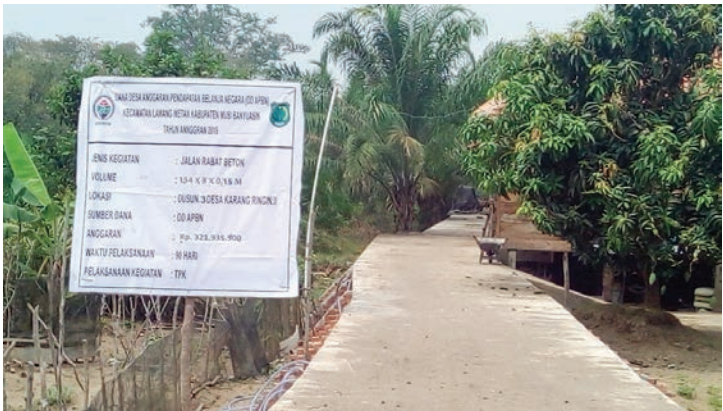
INFRASTRUKTUR: Pembangunan jalan rapat beton sepanjang 154 meter, lebar 3 meter, di Dusun 3, Desa Karang Ringin 2.
